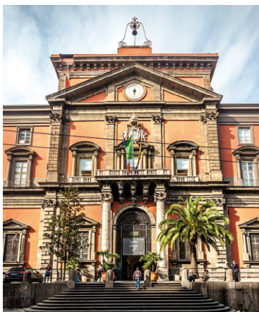
La monumentale façade du palais date du XVI e siècle.
