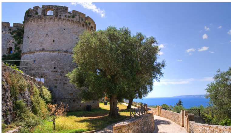
Murs d'enceinte de la ville de Castro.
