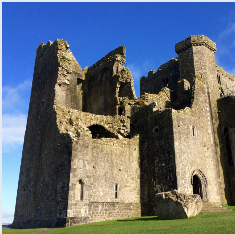
Rock of Cashel, ancienne résidence des rois de Munster.
