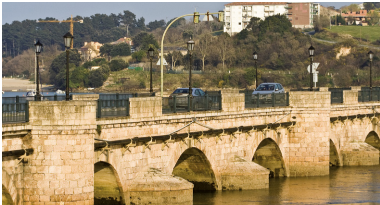
Puente de la Maza.
