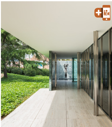
Pavillon allemand créé par l'architecte Mies van der Rohe.
