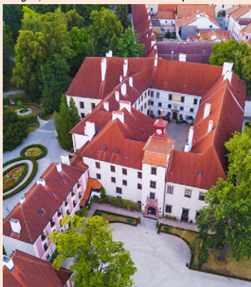
Vue du château Renaissance de Tržebň.
