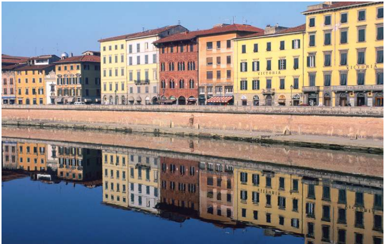
Façades de Pise.
