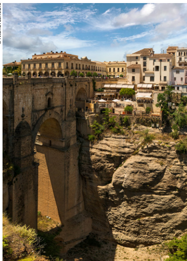
Puente Nuevo, Ronda.
