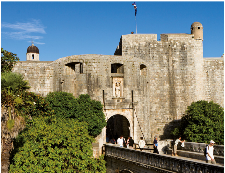
Porte Pile (Vrata od Pila).
