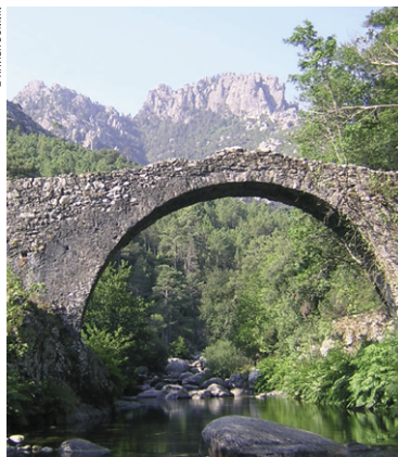
Pont génois sur l'Inzecca.
